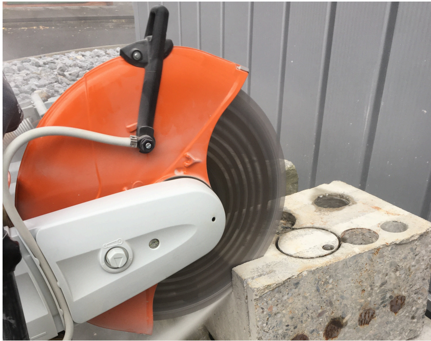
Der Trennschleifer schneidet mühelos durch Stahlbeton – der Diamanttrennscheibe sei Dank
