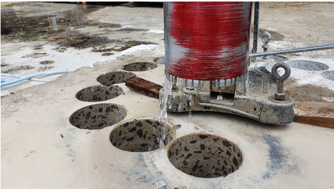
Ein Diamanthohlbohrer im Einsatz © Clever Diamond GmbH
