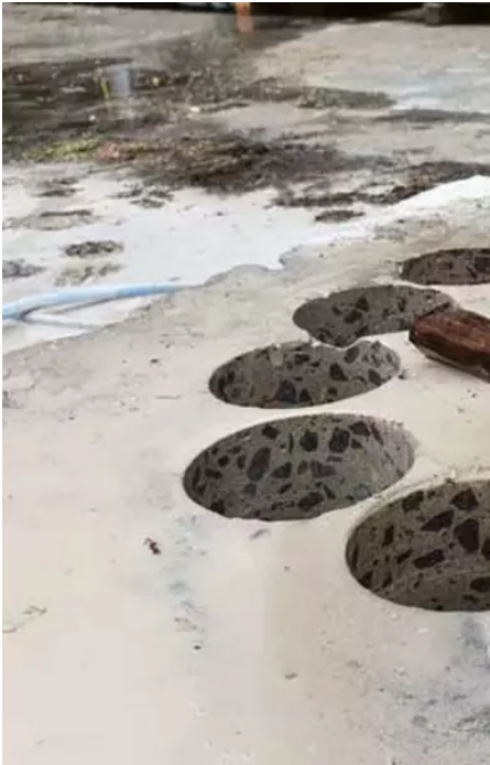
...für Bohrarbeiten auf der Baustelle
